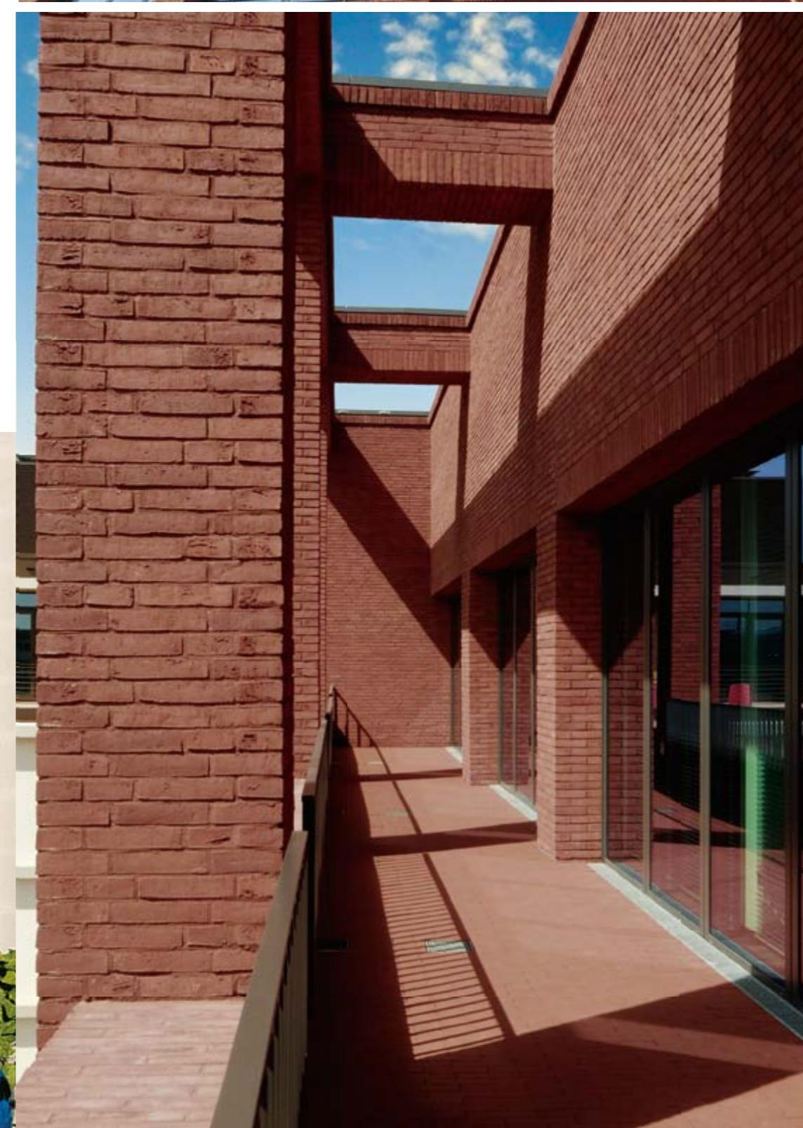
Rote Röben Handstrich-Verblender WIESMOOR mit roter Fuge. Ein monolithisch anmutender Baukörper mit kraftvoller, selbstbewusster Ausstrahlung.
