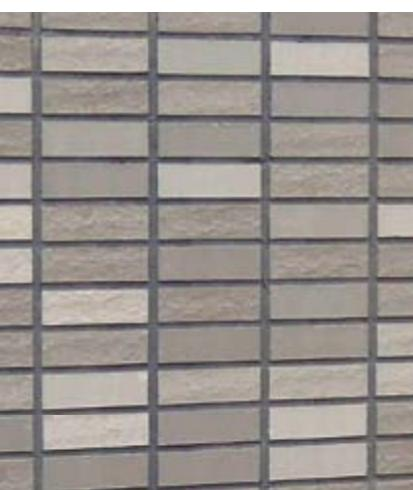
Bürokomplex in Gent (B). Im Prozess des Röben BRICK-DESIGN® wurden die verschiedenen Grautöne des Klinkers präzise neu definiert, die Oberflächenstruktur extrem rau modelliert und die nur 60 mm dicken Sonderklinker der Länge nach halbiert. So entstand das abwechslungsreiche Fassadenbild aus je 50 Prozent strukturierten und rustikal-glatten Oberflächen.
