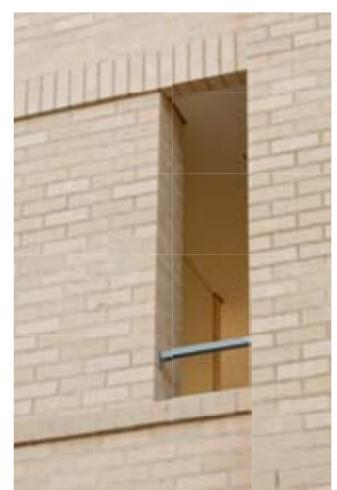
Wohnüberbauung in Brunnmatt-Ost, Bern (CH). Nach den konkreten Vorstellungen der Architekten – der Klinker sollte sandfarben sein und unbehandelt – wurde der Klinker für dieses Projekt entwickelt. Ganz bewusst werden Abplatzungen an den Kanten akzeptiert und diese Rauheit im Mauerwerk noch durch eine rustikal abgezogene Mörtelfuge unterstrichen.
