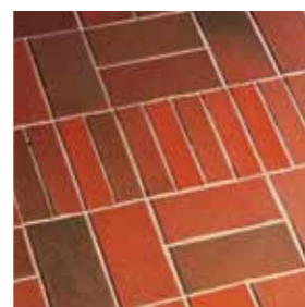
6. Wiązanie blokowe z pasmem ozdobnym z wąskich cegieł
