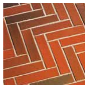
2. Wiązanie w jodełkę z wąskich klinkierowych cegieł brukowych
