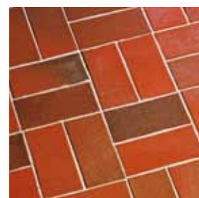
4. Na przemian po dwie klinkierowe cegły brukowe ułożone w przeciwnych kierunkach
