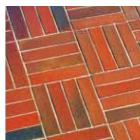
7. Na przemian po cztery wąskie klinkierowe cegły brukowe ułożone w przeciwnych kierunkach
